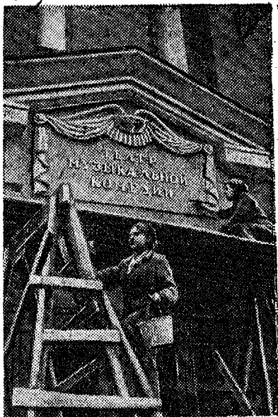
Заканчиваются восстановительные работы в Театре музыкальной комедии Фото Д. Трахтенберга
