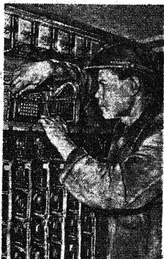
В новом Центральном театре Красной Армии. На снимке: монтер Г. Пятко проверяет работу электрического электропульты на сцене театра.
