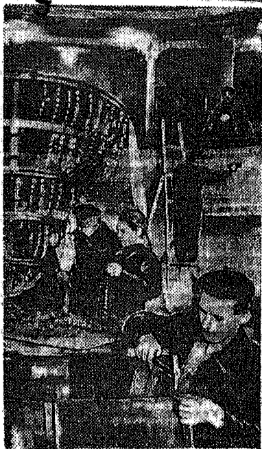
Ремонт зрительного зала Театра революции.
