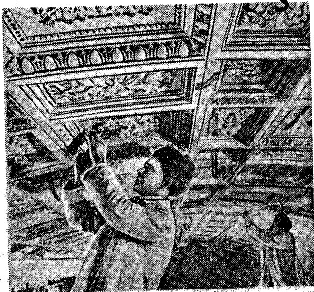
На площади Журавлева строится театр Сталинского района. НА СНИМКЕ: мастера Жуков и Каутов украшают потолок фойе первого этажа лепными орнаментами. Снимок Б. Ярославцева.
