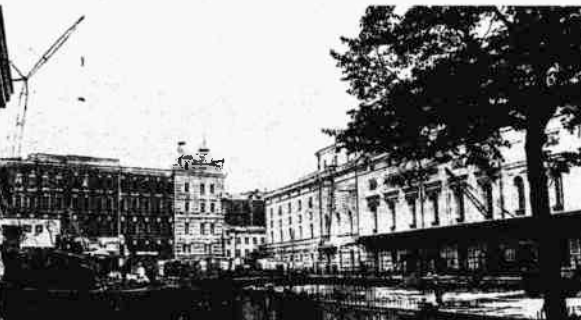
Строительство парадного инженерного блока Большого театра
