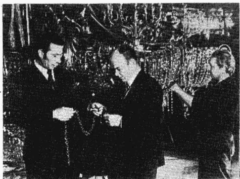
1. Начальники участка В. Шиффер, главный инженер театра и КДС А. Жаворонков и монтажник В. Мironov за сборкой галвальной листы.
