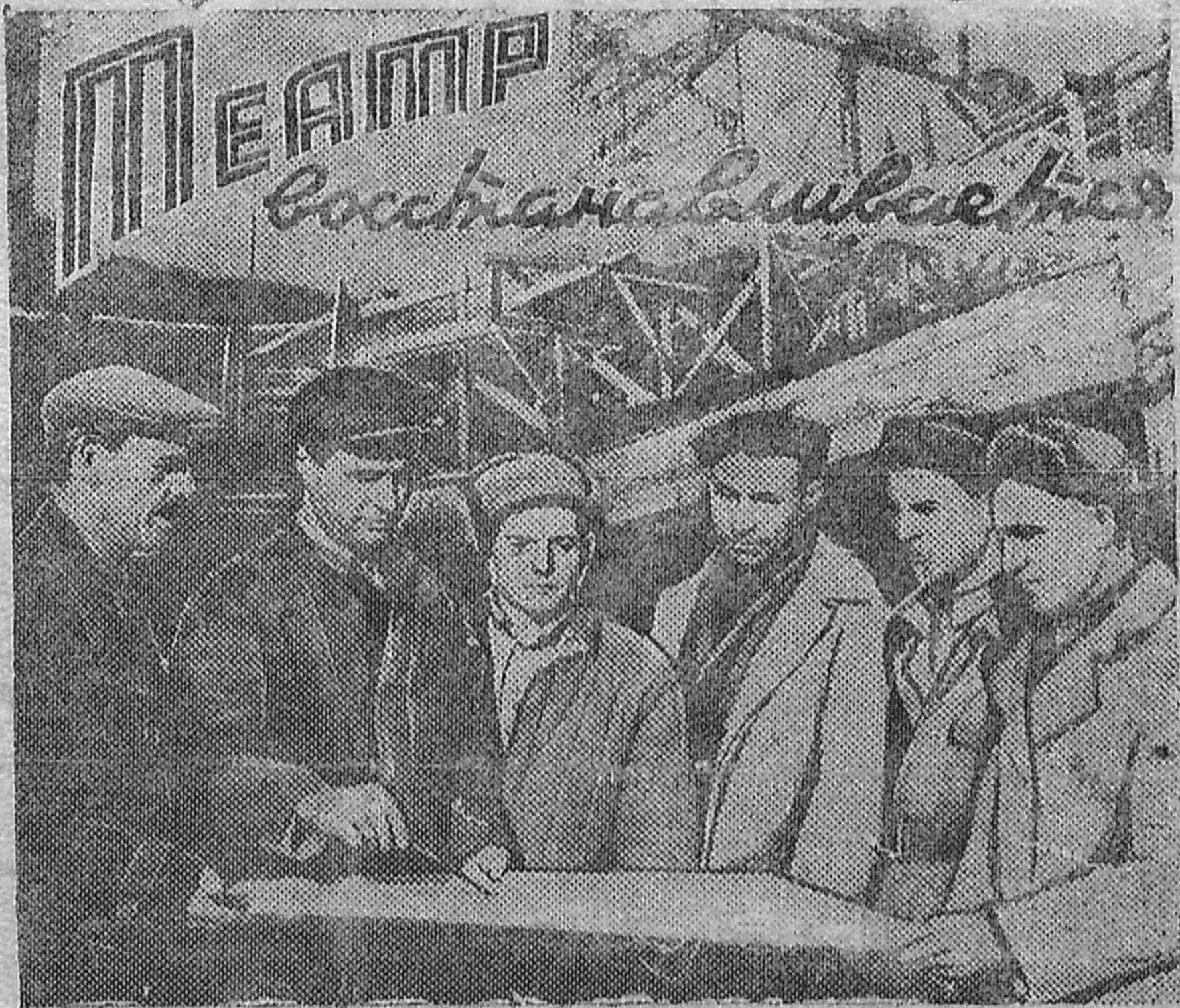
Таганрогский участок треста «Стальконструкция» (начальник т. Гинзбург, прораб т. Сиротин) закончил в театре имени А. П. Чехова монтаж металлоконструкций. За десять дней установлено пять ферм, являющихся основой кровли и потолка театра.
