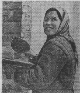
Штукатур стройтреста № 123 В. Прокопьева, соревнуясь с маляром Йошкар-Олинского завода торгового машиностроения Э. Изергиной, в предпраздничные дни выполняет норму не менее чем на 180 проц.
