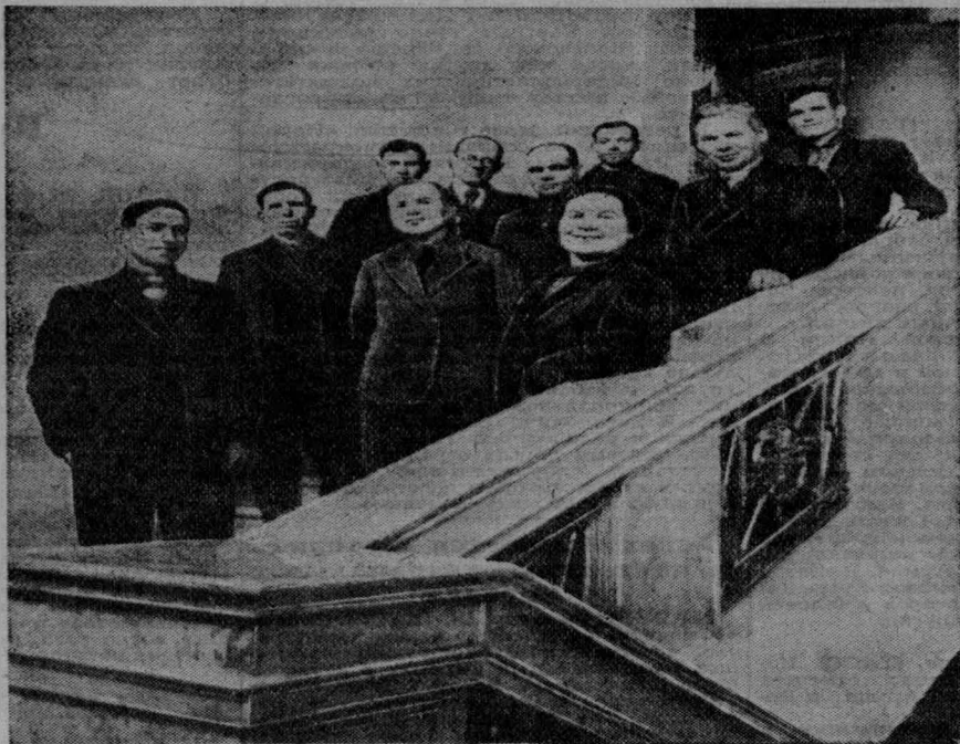
На снимке (слева направо): группа строителей Челябинского театра оперы и балета—(первый ряд) Ф. Мищенко, бригадир паркетчиков; П. Соппиков, бригадир маляров; А. Лапаев и Е. Жданова—маляры; (второй ряд) И. Сотников, бригадир штукатуров; П. Михеев, бригадир электромонтажников; П. Мелехин, мастер; Ф. Орехов, бригадир сантехмонтажа; Ф. Плотинов, начальник участка; С. Воханцев, столяр.
