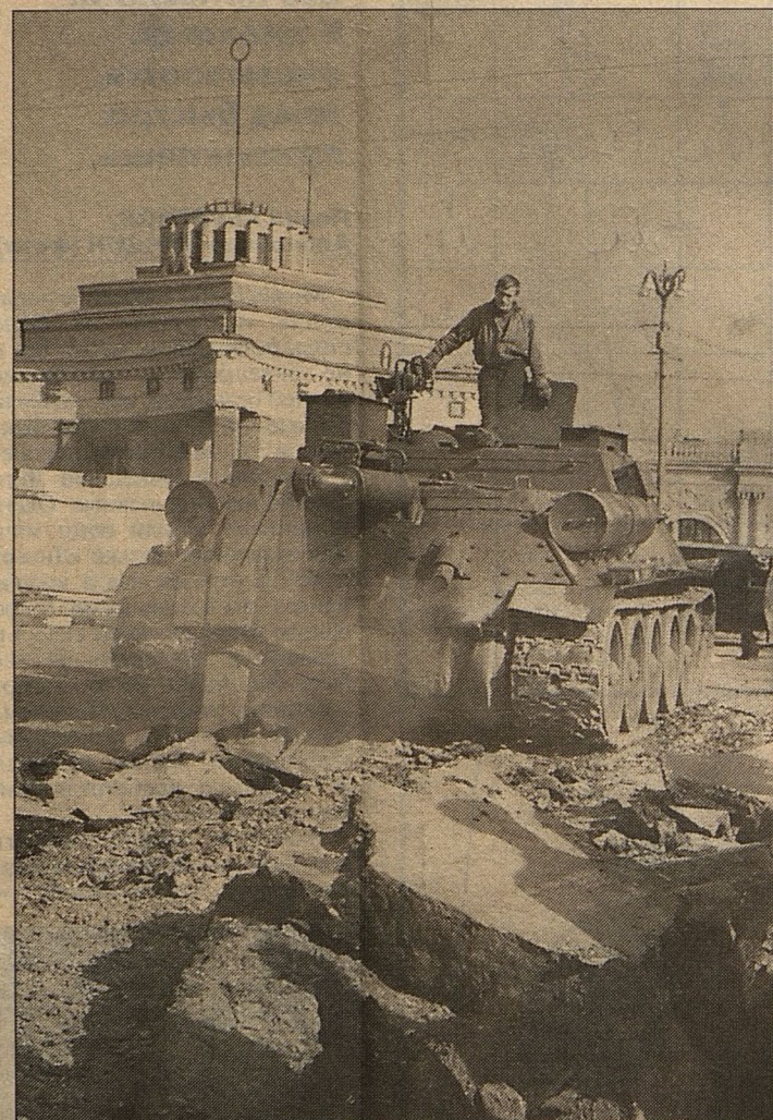
Тяжелая военная техника на строительстве тоннеля под Арбатской площадью. 1963 г.
