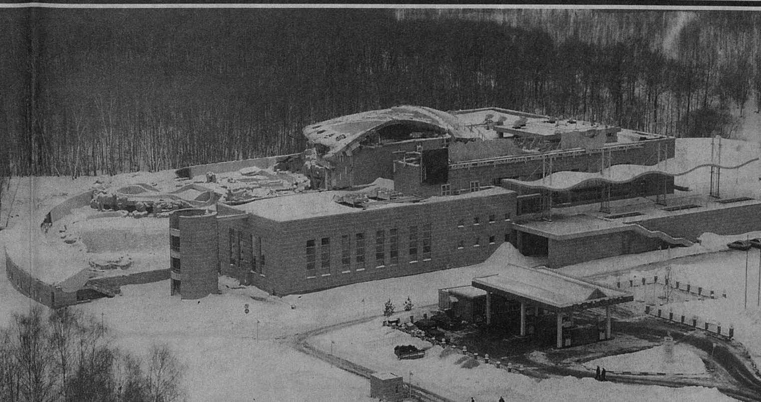
Годовщина катастрофы. Обломки кровли не вывезены до сих пор
