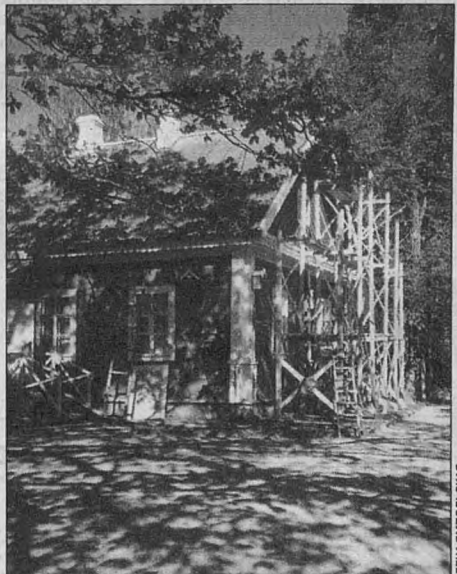
Дом Гейченко на реконструкции.
