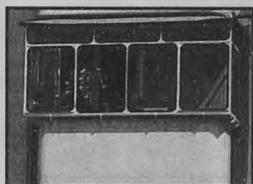
Рамы — грунтованное железо, сварная конструкция. Стекла — полированные, любого размера.
