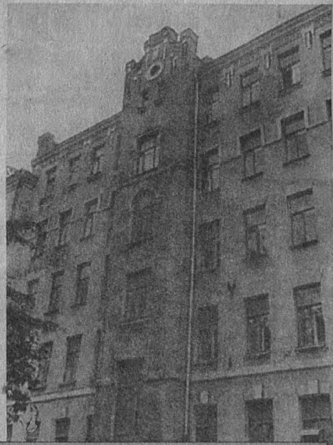
фрагмент фасада здания школы № 273.
