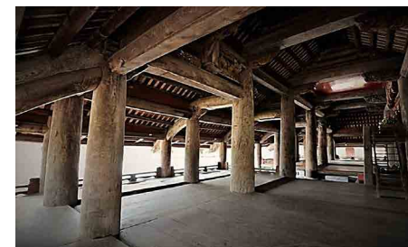
Рис. 3. Балочно-стоечная опорная система диня Чукуен (Ханой). XVI в.
